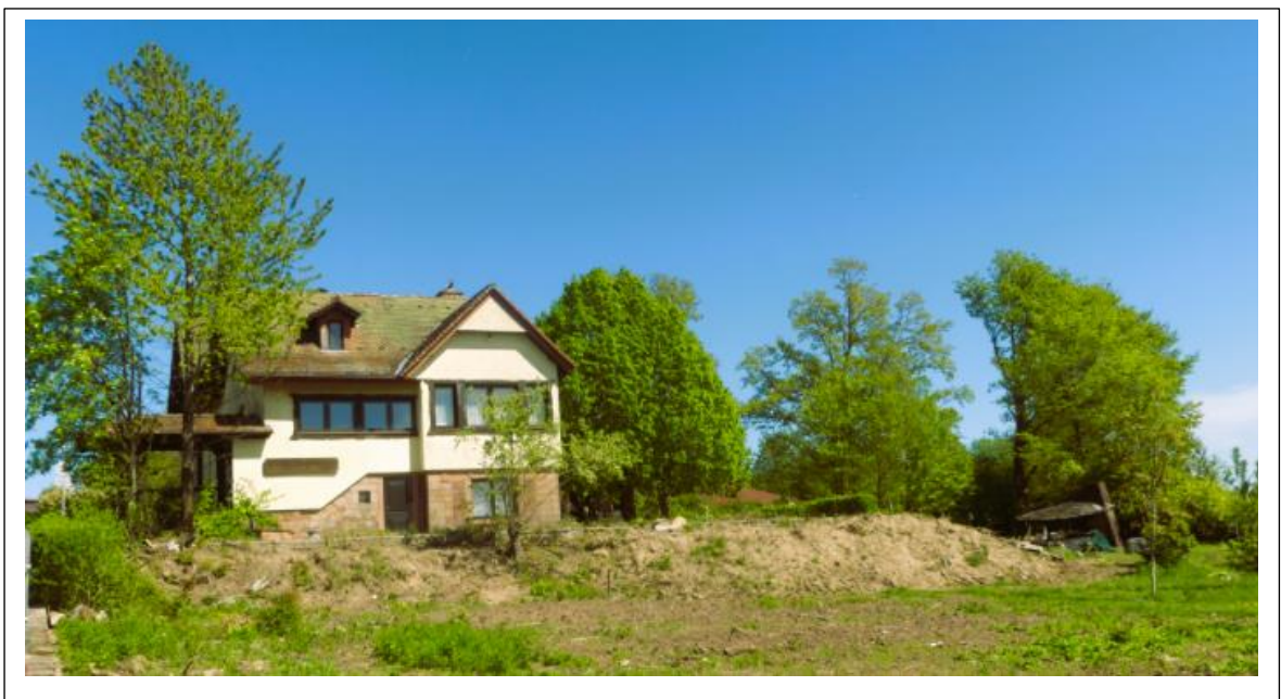
Abb. 15: Gebäudeansicht aus Westen mit teilberäumter Grundstücksfläche und dem im April 2026 noch verbliebenen Baumbestand im Nordosten des Plangrundstücks Flst.-Nr. 340
