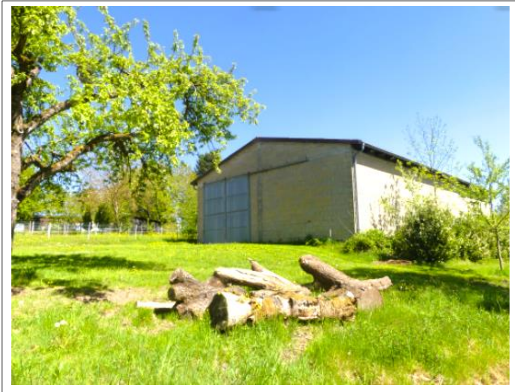
Abb.08: Die in Massivbauweise errichtete Landwirtschaftshalle des Grundstücks Flst.-Nr. 342/2 umfasst eine Grundfläche von etwa 25 m x 14 m → 350 m 2 . Die Firsthöhe beträgt überschlägig 8,50 m. Die Halle wird durch einen 24 m langen und zwischen 3,50 m und 5,50 m breiten Schotterweg von der Höhenstraße aus erschlossen.
