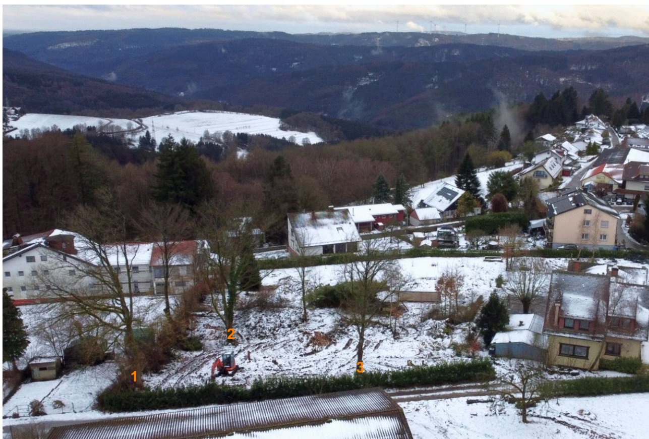
Foto 1: Verbliebene Bäume 1 bis 3 nach Baufeldräumung (Aufnahme vom 16.02.2026)
