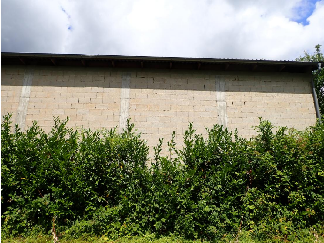
Abb. 13: Die Fassaden der Halle sind unverputzt, es kommen einige geeignete Hohlblocksteine mit Spalten für Fledermäuse vor.
