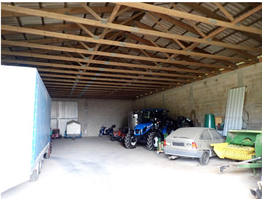
Abb. 7: Auf Höhe der Fußpfetten, Einziehen eines Dachbodens zum Erhalt von Lebensstätten von Fledermäusen im Dachstuhl.
