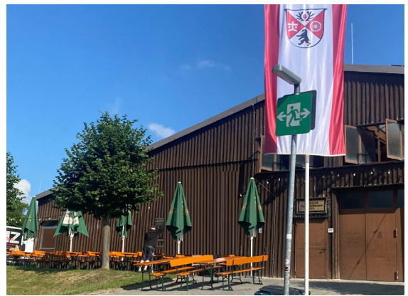
Festhalle, Aufbau Biergarten
