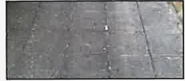
Belag mit Fugenverguss
